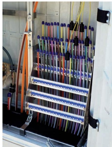
**Bild oben: High-Tech im Verteilerkasten: Jedes dieser Röhrrchen führt zu einer einzelnen Abnahmestelle.**
